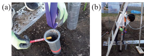
第4図 チェーンブロックを用いた鉄パイプの引き抜き手順。銅棒を鉄パイプの穴に挿入する際、棒にソフトフックをかけ (a)、そのソフトフックを脚立に取り付けたチェーンブロックにより引き上げ、鉄パイプを引き抜いた (b)。
